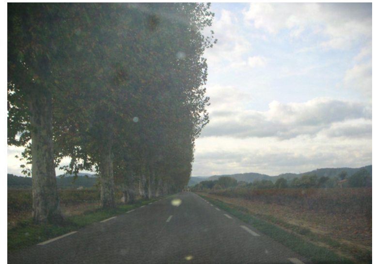
Route Départementale RD 562
